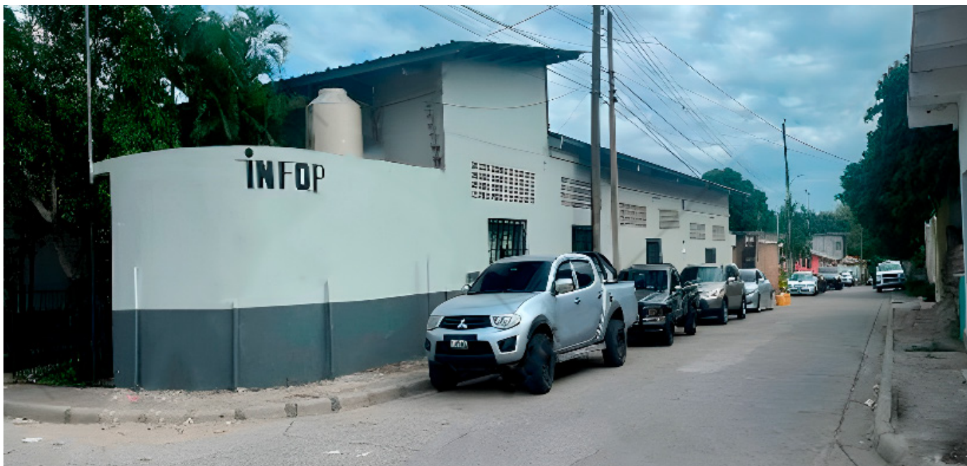
FIGURA 6: INSTALACIONES DEL INFOP, LA PAZ.
